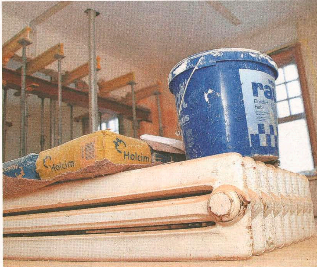
Noch geben Bauarbeiter den Ton an im künftigen Besucherzentrum der Sternwarte. Historische Relikte wie die alten Fenster, Türen und Heizkörper des 1910 errichteten Gebäudes werden erhalten.
